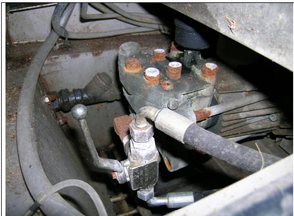
9: Materialerne er generelt af tilfredsstillende kvalitet og kan tåle det hårde vaskemiljø. Enkelte bolte og bøsninger på højtryksrenseren er ikke rustfri, hvilket straks ses. Levetiden er stærkt nedsat på disse komponenter. Robotten på billedet er under to år gammel. Jf. Skiold er det ændret til rustfri bolte nu.
